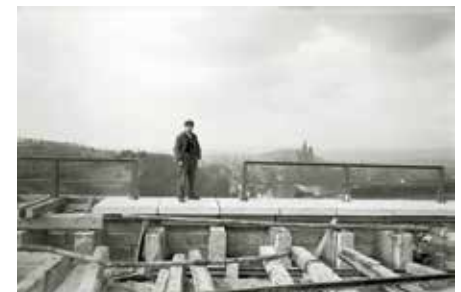
Bild 1: Bau der Lahntalbrücke 1937–1939. Oben: am Grund der Lahn; Mitte: zweifach verwendete Lehrgerüste aus Holz; unten: Limburger Dom im Hintergrund [7]
