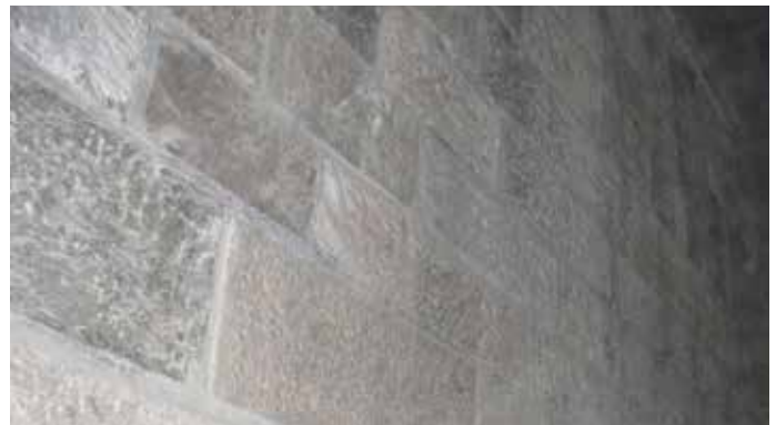
Bild 8: Natursteinverkleidung (Westseite) der Brücke von 1939
