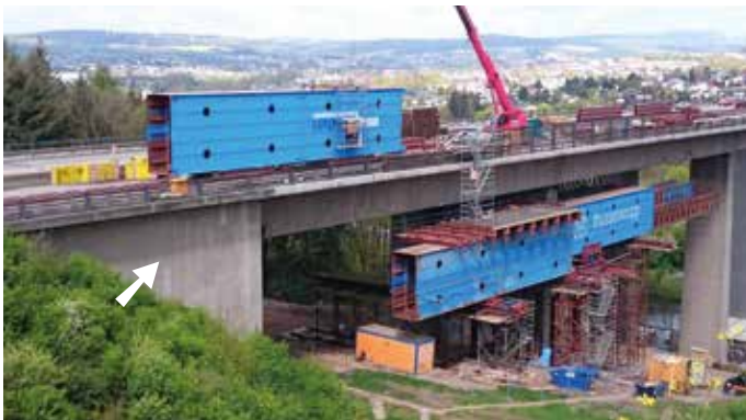
Bild 7: Südliches Widerlager der Brücke von 1965
