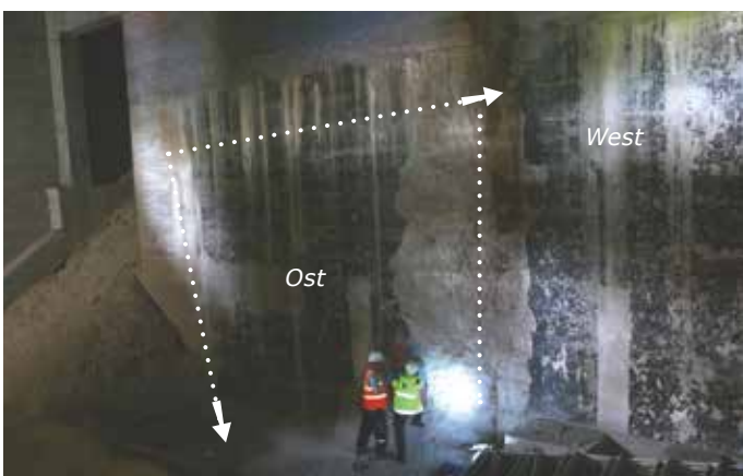
Bild 9: Mitarbeiter des FEhS-Instituts bei der Probenahme am südlichen Widerlager der Brücke von 1939
