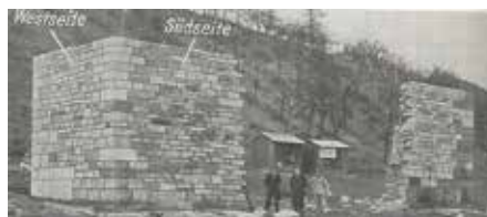
Bild 4: Probemauerwerk für die Steinverkleidung [6]
