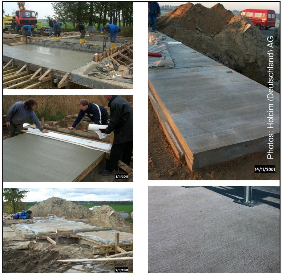
**Bild 1:** Glätten und Nachbehandlung von Brückenkapfen, je eine mit CEM II/B-S 32,5 R bzw. CEM I 32,5 R-NA ( $z = 340 \text{ kg/m}^3$ ,  $w/z = 0,50, 0,30 \text{ M.-%}_Z \text{ LP}$ ), 2001 unten rechts: Zustand nach 3 Wintern 2004 [4]
