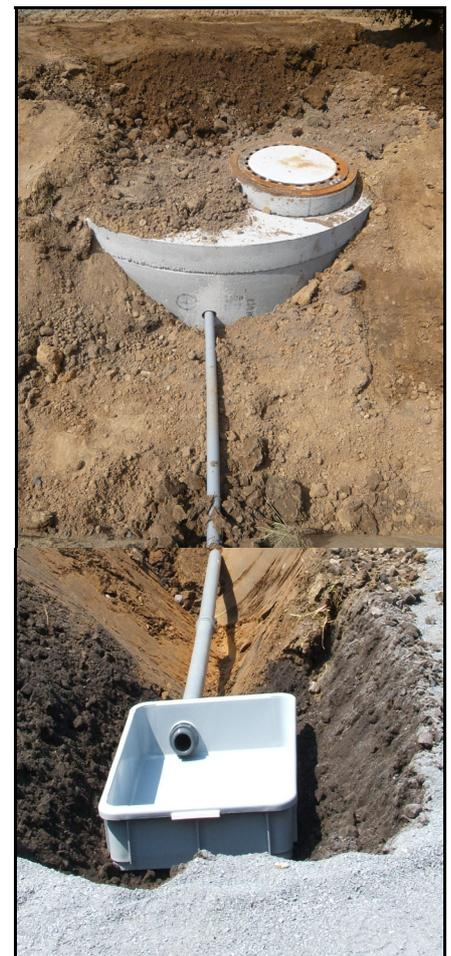
**Bild 2:** Einbau eines Auffanggefäßes mit Zuleitung zum begehbaren Schacht
