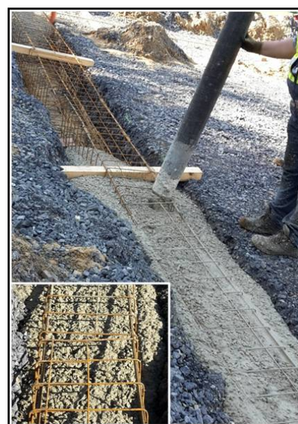
Bild 5: Betonage der Streifenfundamente mit Beton C25/30 unter Verwendung von Hüttensandmehl als Betonzusatzstoff
