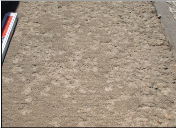
Bild 5: Oberflächenbeschädigung der Brückenkappe Dausfeld (Fahrtrichtung Köln)
