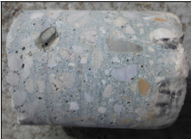
Bild 7: Homogener, gut verdichteter Beton; Bohrkern 1.3, Brückenkappe Dausfeld (Fahrtrichtung Trier)
