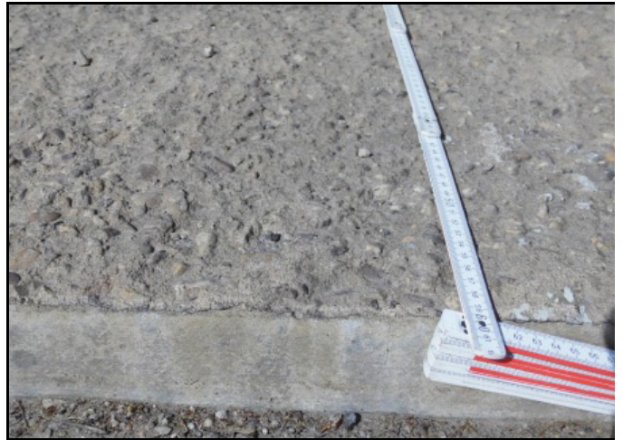
Bild 6: Oberflächenbeschädigung der Brückenkappe Dausfeld (Fahrtrichtung Trier)
