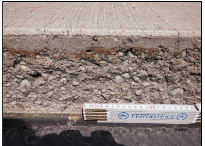
Bild 8: Schadensbild am Schrammbord der Brückenkappen in Auw / Kyll
