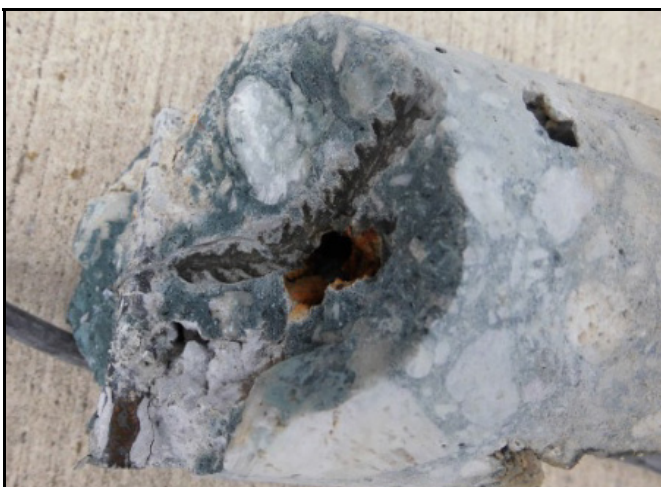
Bild 9: Verdichtungsfehler; Bohrkern 6.1, Brückenkappe Auw / Kyll
