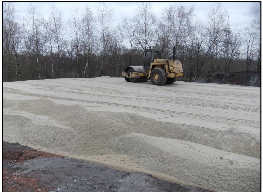
Bild 1: Aufbau des 3.000 t fassenden Hüttensand-Versuchslagers 2011
