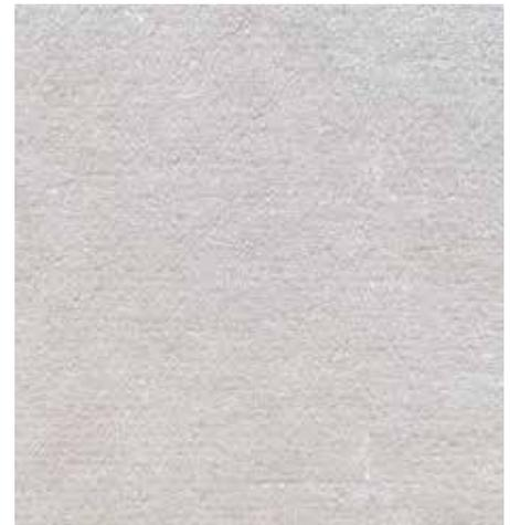
Bild 4: Poren- und lunkerfreier Betonwandausschnitt
