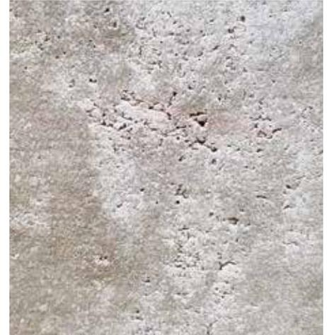
Bild 3: Betonwandausschnitt mit Poren/Lunker
