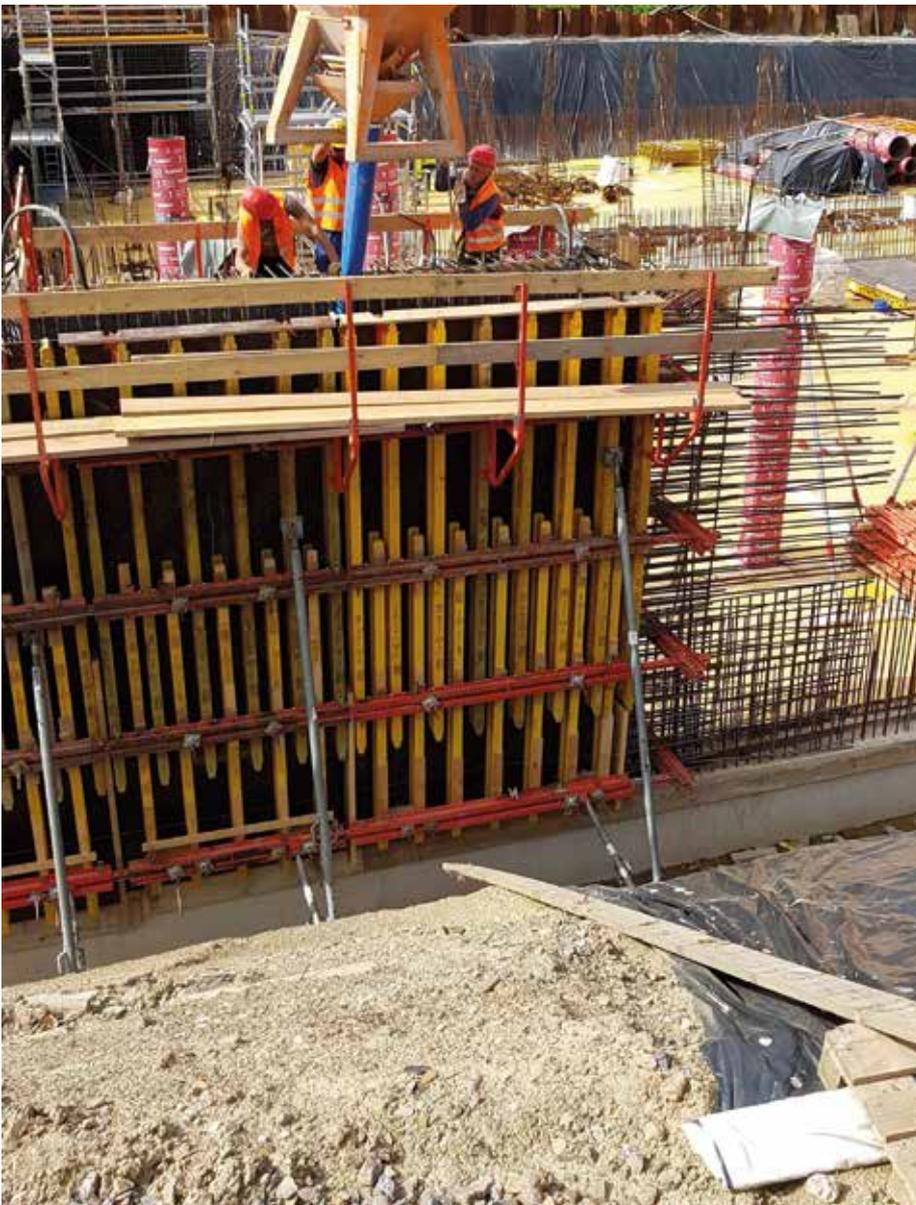
Bild 2: Betonage des 1. Wandabschnittes
