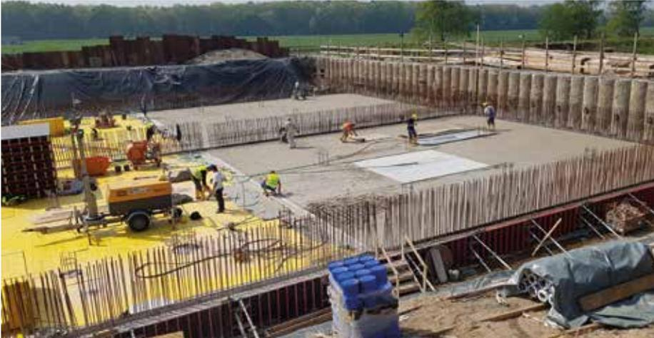
Bild 1: Betonage des 4. Sohlabschnittes
