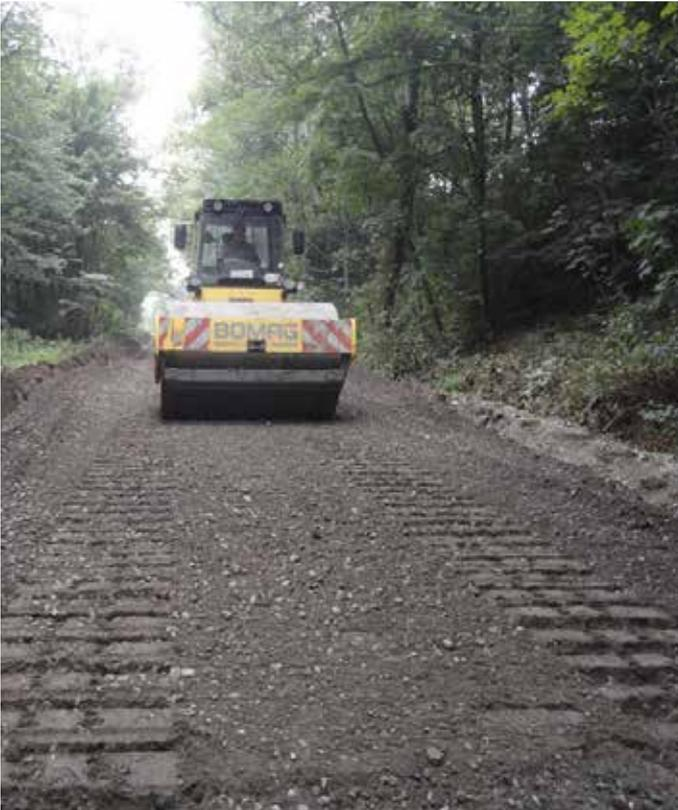
Bild 3: Verdichtung der Baustoffgemische bzw. Streckenabschnitte
