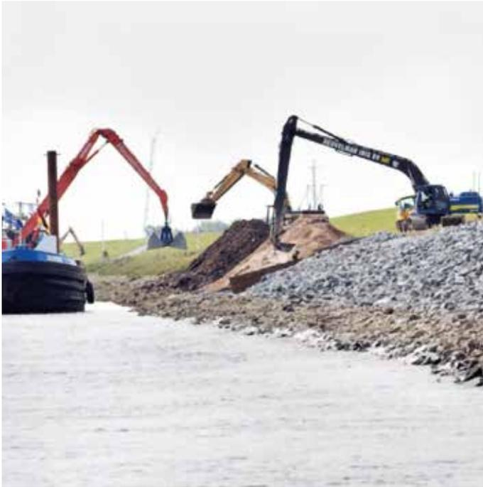
Bild 1: Herstellung eines Deckwerks zur Böschungssicherung aus Gesteinskörnungen; Wasserbausteine (Deckschicht) und Kornfilter
