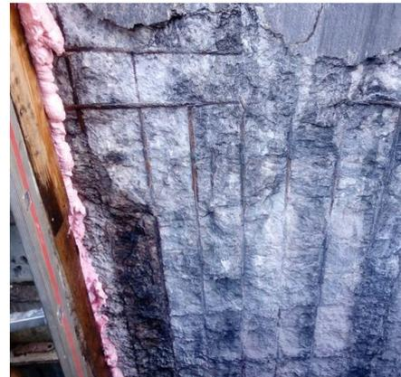
*Bild 1: Bei 800 °C geschädigter Abluftkanal einer Kokerei*
