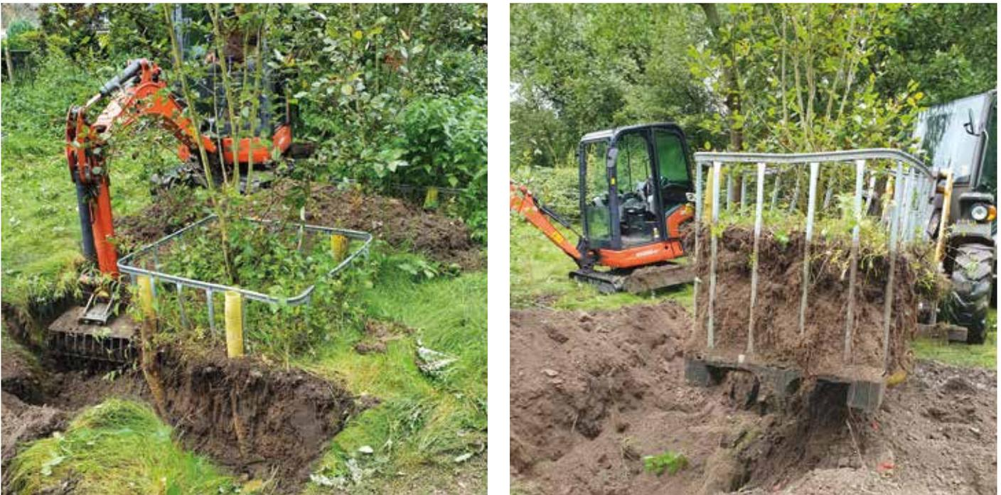
Bild 3: Freilegen der Pflanzkörbe (links) und Aushub des gesamten Pflanzkorbes samt Baums substrat und Weide (rechts)
