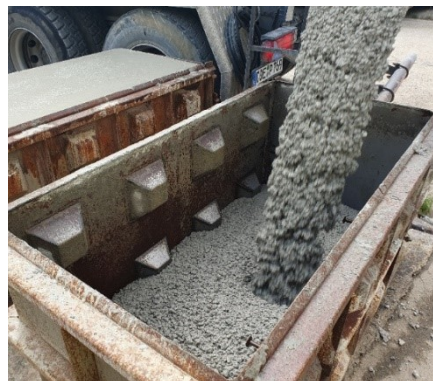
Bild 3: Herstellung der "Legosteine" im Transportbetonwerk
