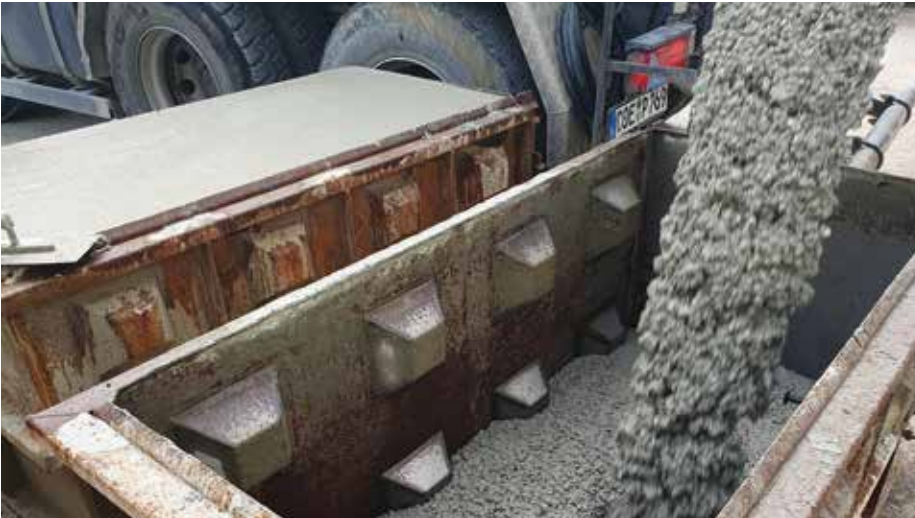
Bild 9: Herstellung der „Legosteine“ im Transportbetonwerk der Spenner Herkules GmbH
